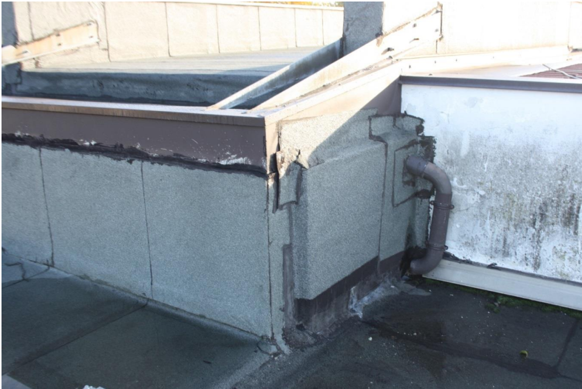
“A” Copertura Nord – Blocco pluviale nord-est
