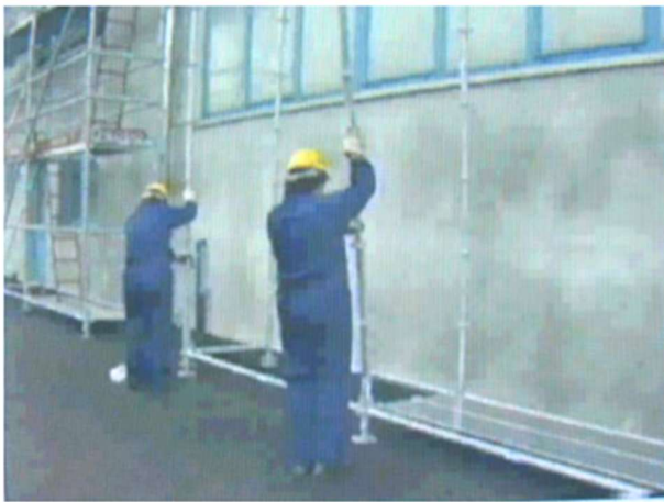
ULTIMAZIONE SMONTAGGIO E STOCCAGGIO DEGLI ELEMENTI
