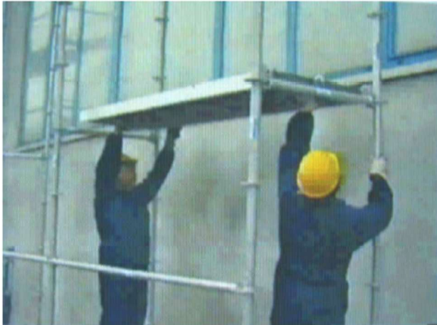
POSA PRIMO IMPALCATO DAL BASSO
