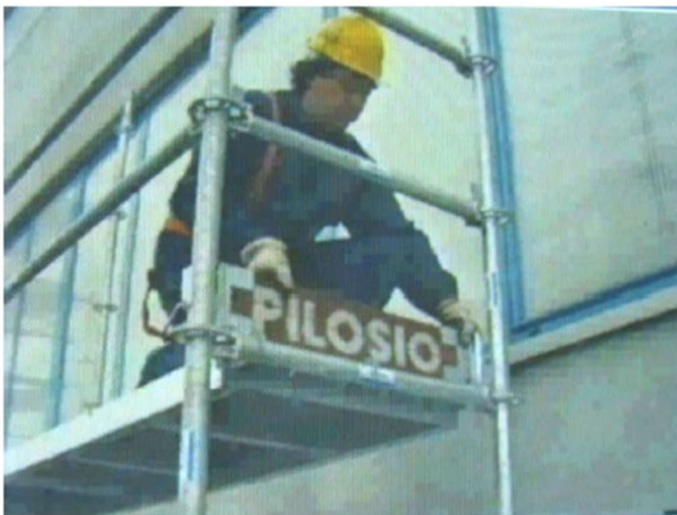
POSA IMPALCATI SUPERIORI
