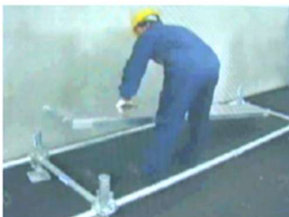
MONTAGGIO TAVOLE IMPALCATI
