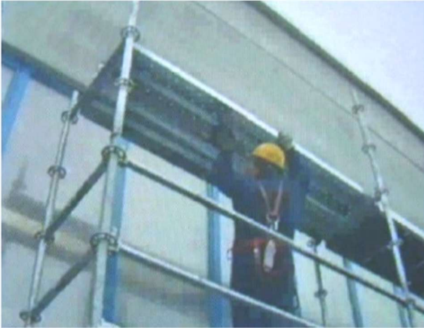
OPERAZIONI DI SMONTAGGIO DALL'ALTO
