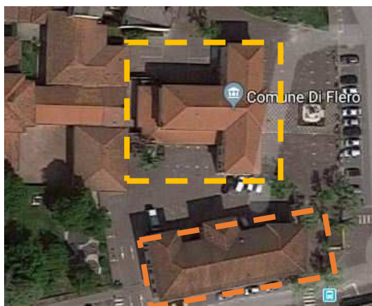
Figura 1 – Vista satellitare del Municipio: Edificio Principale (giallo) Ex Scuole (ocra)
