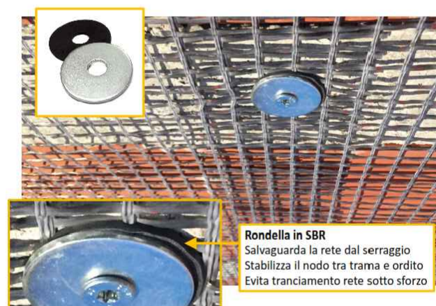
RONDELLA VITI AUTOFILETTANTI FISSAGGIO AL TRAVETTO
