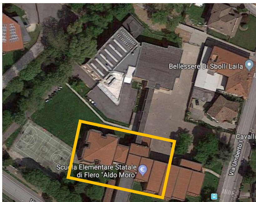
Figura 1 – Immagine satellitare con la posizione della scuola oggetto d'intervento
