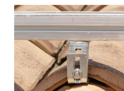
DETTAGLIO POSIZIONAMENTO STAFFA su COPPO
