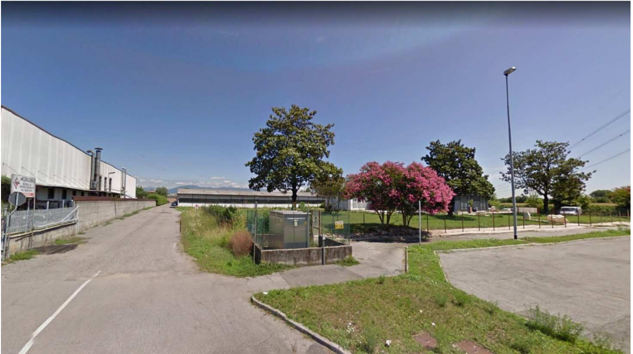
5. da via XX Settembre angolo sud-ovest del lotto d'intervento scatto fotografico in direzione nord
