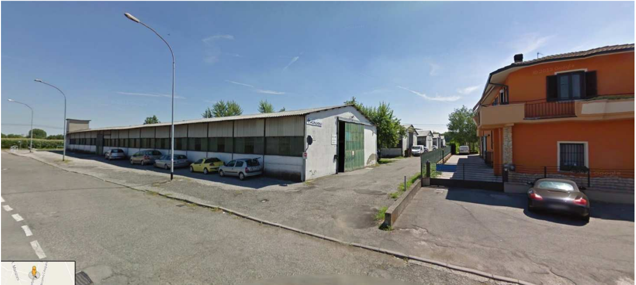
10. angolo nord-ovest del lotto d'intervento scatto fotografico in direzione sud-est, da via Zerbino
