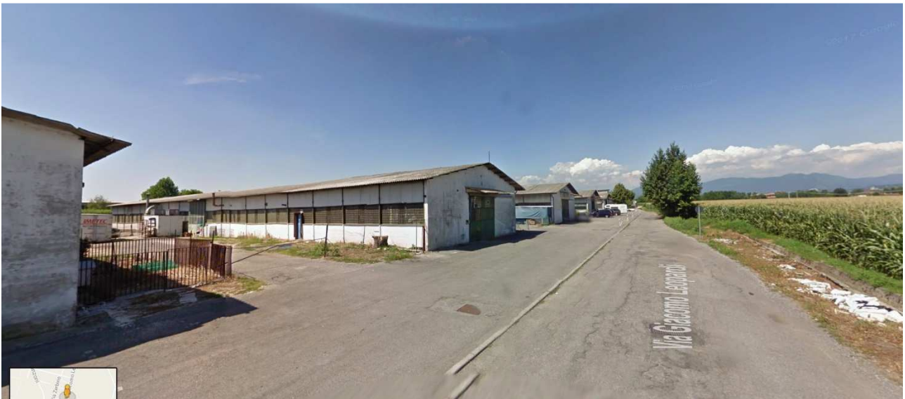
7. da via Leopardi lato est del lotto d'intervento scatto fotografico in direzione nord
