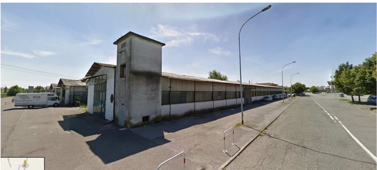
9. angolo nord-est del lotto d'intervento scatto fotografico in direzione sud-ovest, tra via Leopardi e via Zerbino
