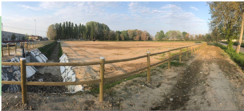
Vasca di Laminazione in Via L. Pirandello
