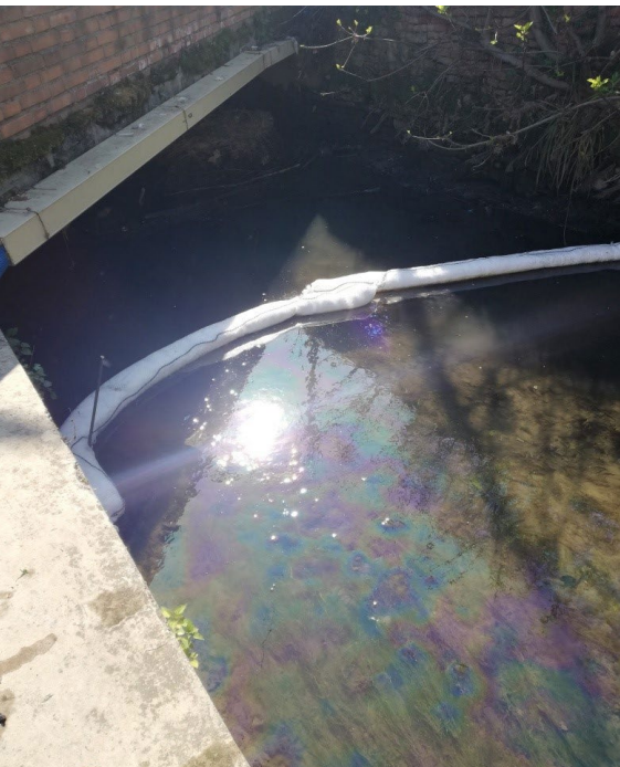
1. Barriere assorbenti sul vaso Fiume a Poncarale
